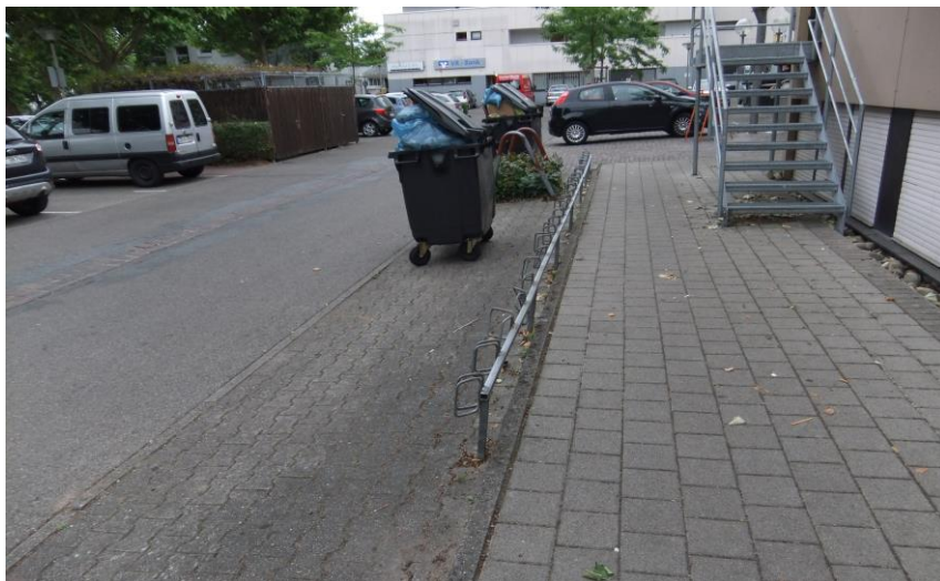
Nicht genutzte und unbrauchbare Fahrradabstellanlage bei Parkplatz 5, zudem gefährliche Stolperfalle
