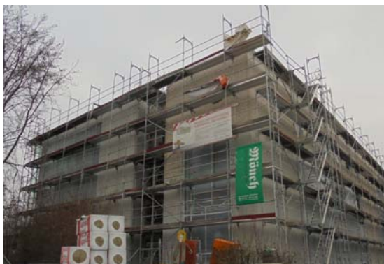
Abbildung 15: Neubau „Kita Murmel“ in Heutingsheim (Quelle: WHS, 2019)
