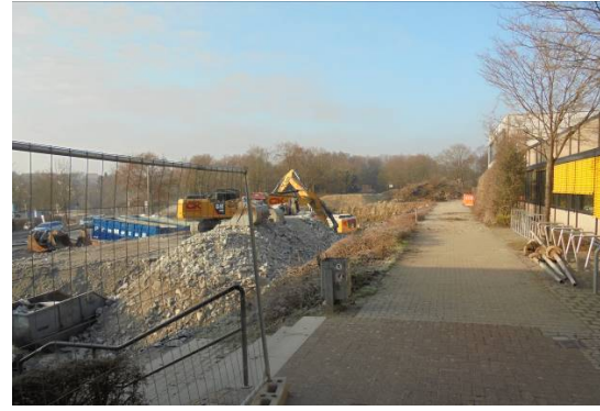
Abbildung 18: Oscar-Paret-Schule, Baubeginn (Quelle: WHS, 2019)
